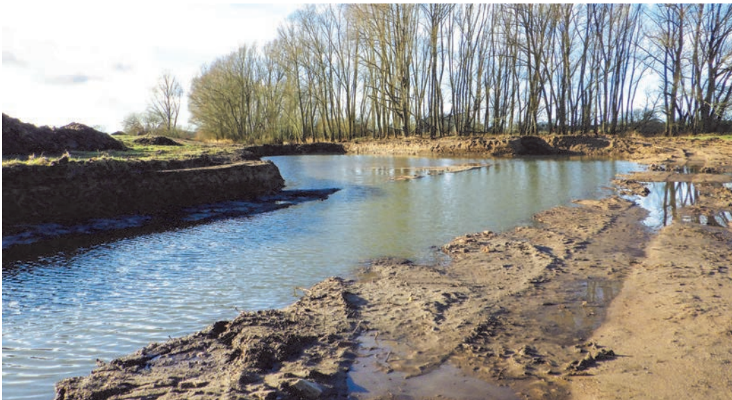
Der zukünftige Einlauf der "Alten Aller" mit bereits angelegter Furt für die Überquerung mit landwirtschaftlichen Maschinen.
