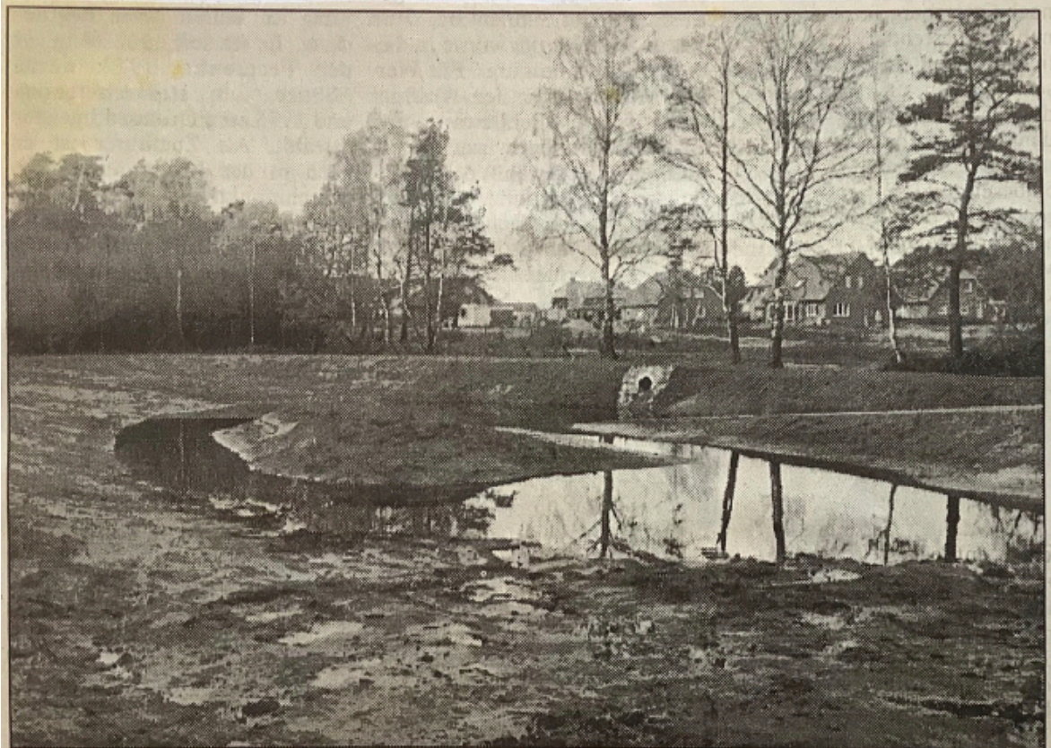
Um einen See reicher ist die Gemeinde Kirchlinteln. Unterhalb des Neubaugebietes „Rüstkamp“ in Luttum wurde ein neues Regenrückhaltebecken gebaut, das sogar mit einer kleinen Insel versehen wurde und sich bereits in wenigen Jahren harmonisch in die Landschaft einfügen dürfte. Foto Reineke
